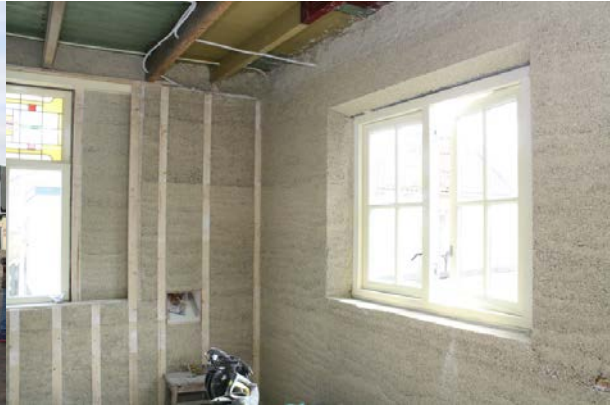
In het werk gestorte kalkhenep. Ook hier zijn is de kalkhenep tegen de bestaande steens muren aangebracht. Met speels gemak wordt de aansluiting gevonden met andere bouwdelen.
