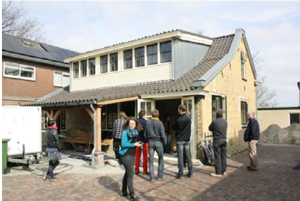
Het pand is flink onder handen genomen. Mét een dakkapel over de volle breedte.
