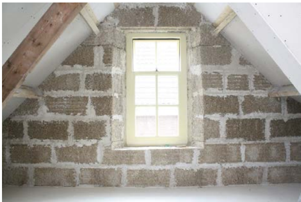
Omdat in het werk gestorte kalkhenep op de bovenverdieping lastig is aan te voeren is hier gebruik gemaakt van kalkhenepblokken. De ruimte tussen de bestaande steens muur en blokken wordt opgevuld met een kalkhenep mengsel. Met wat handigheid wordt hier ook een hoge mate van kierdichtheid bereikt.
